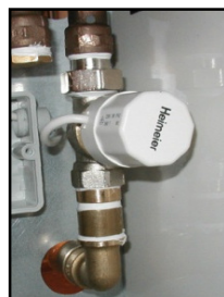
Abbildung des eingebauten elektrothermischen Ventils
