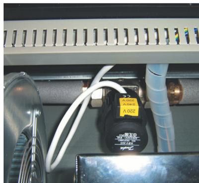
eingebautes thermoelektrisches Ventil regelt die Temperatur der Abluft, bzw. der Raumluft
